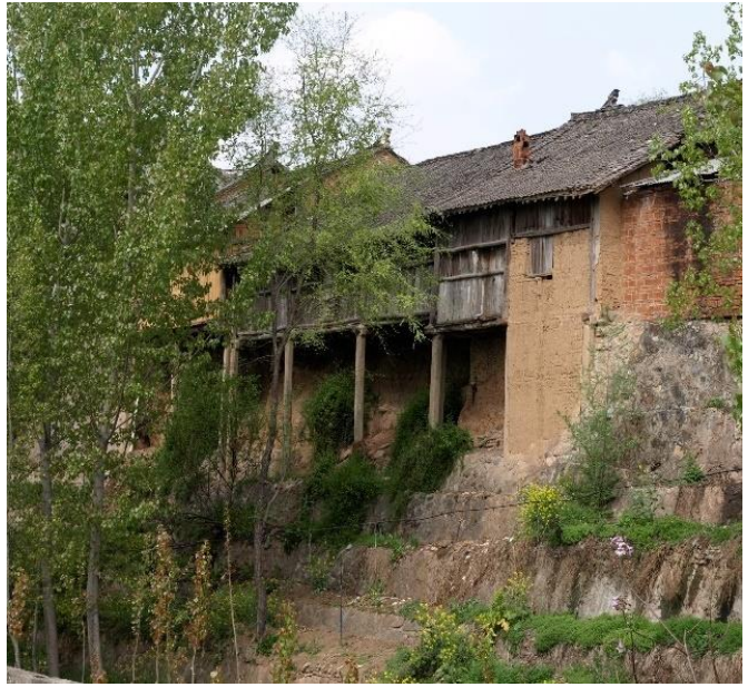
写真 5-28 長い柱に支えられた吊脚楼
